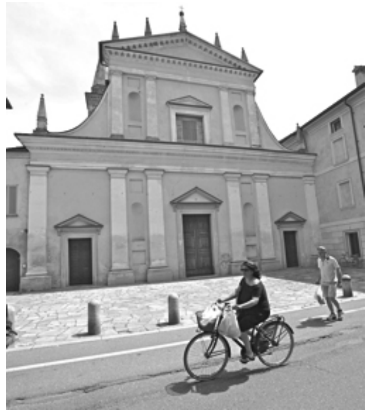
La chiesa della Trinità: ieri i tecnici erano al lavoro all'interno dell'edificio
