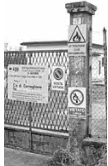
Il sito di Cornegliano (foto d'archivio)
